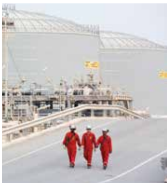
OPSLAGINSTALLATIE PEARL GTL, QATAR
