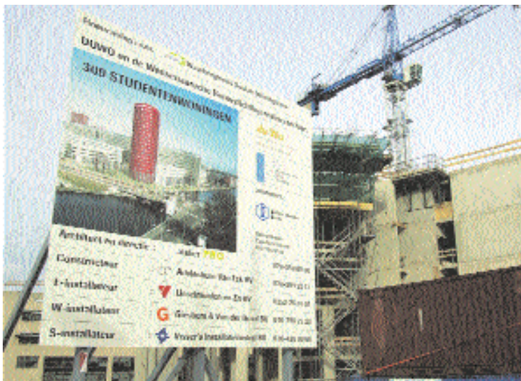
Collegiale financiering DUWO/ Wassaarsche Bouwstichting © René Verleg
