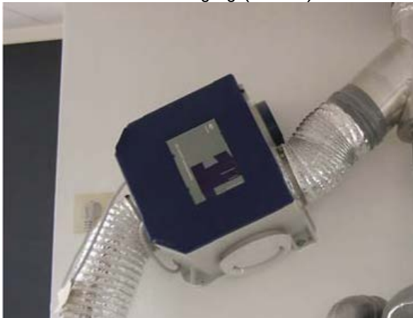
Afb. 13 Ventilatieunit voor enkel mechanische afzuiging
