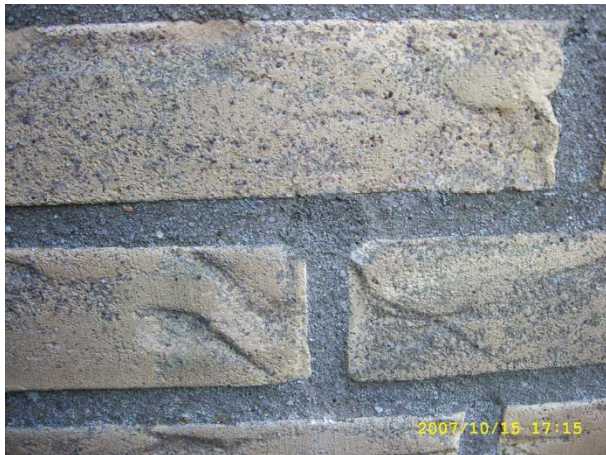
Afb. 3 Boorgat in de gevel
