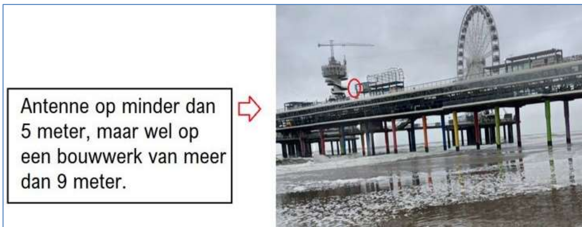
Figuur 8: De antennedragers in Scheveningen staat op een bouwwerk van meer dan 9 meter.
