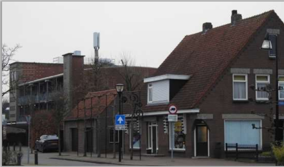
Figuur 27: Antennes van hoog vermogen (Wijk en Aalburg).
