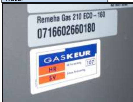
Afb. 9 CV-ketel met HR keur (HR107)
