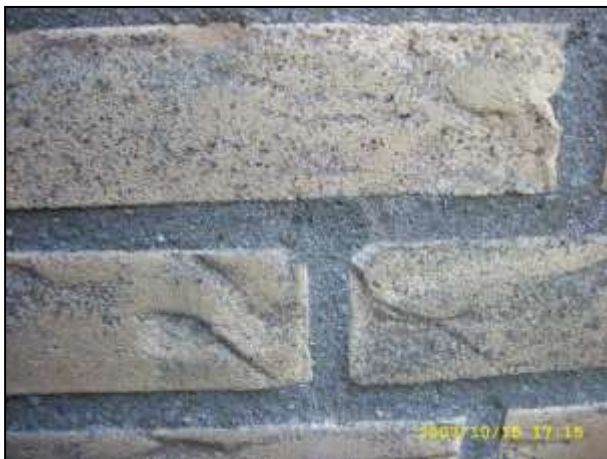
Afb. 3 Boorgat in de gevel
