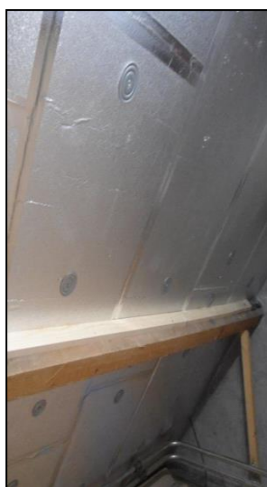
Afb. 6 Isolatie op vliering tussen de gordingen
