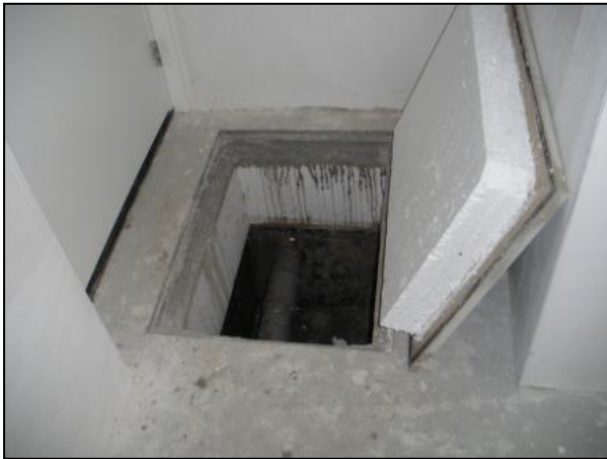
Afb. 7 Isolatie in de vloer
