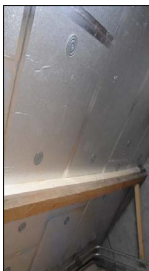
Afb. 6 Isolatie op vliering tussen de gordingen
