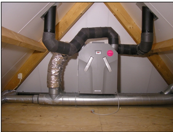
Afb. 14 Ventilatieunit voor mechanische toe- en afvoer van lucht (gebalanceerd ventilatiesysteem)
