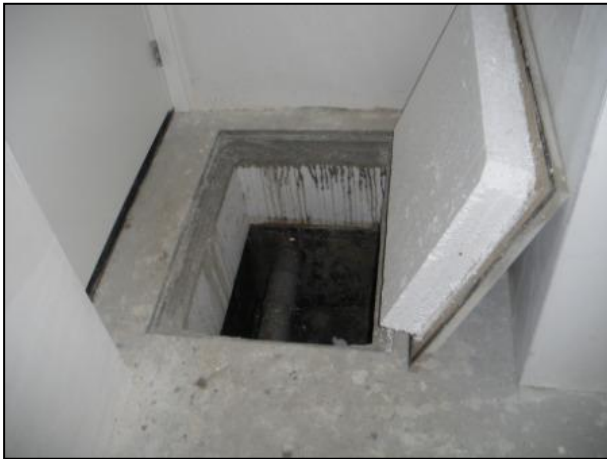
Afb. 7 Isolatie in de vloer
