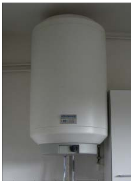
Afb. 12 Elektrische boiler (links) en geiser (rechts)
