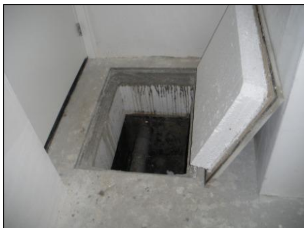
Afb. 7 Isolatie in de vloer
