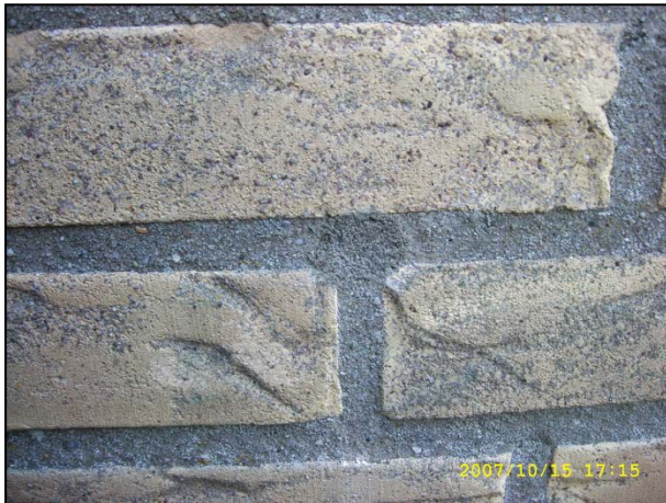
Afb. 3 Boorgat in de gevel
