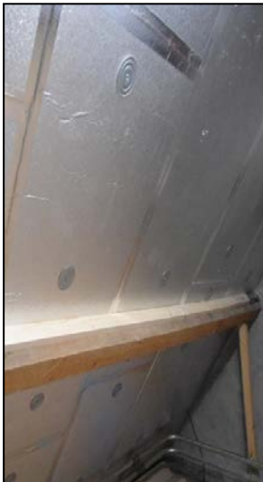
Afb. 6 Isolatie op vliering tussen de gordingen
