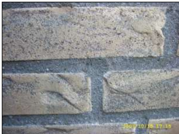
Afb. 3 Boorgat in de gevel
