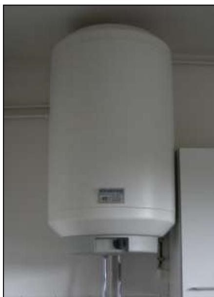
Afb. 12 Elektrische boiler (links) en geiser (rechts)
