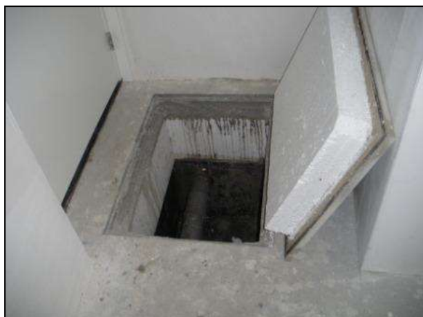
Afb. 7 Isolatie in de vloer
